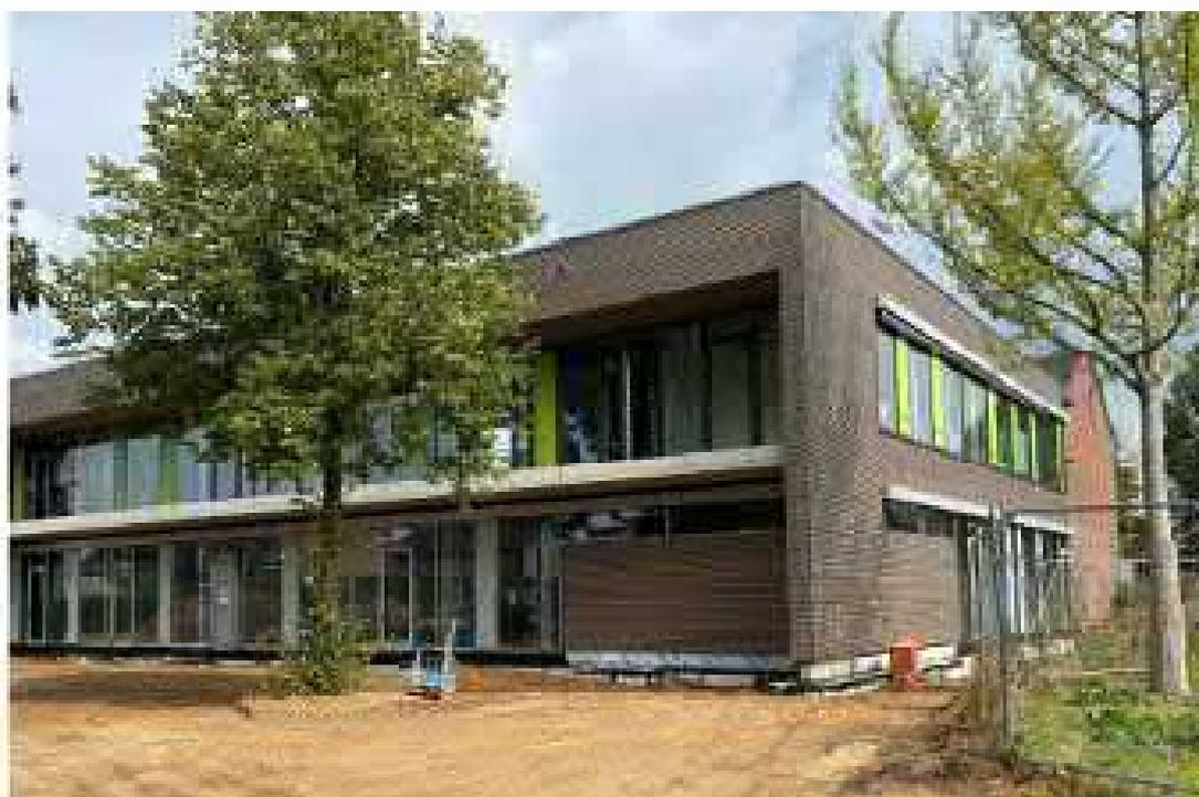
Die Rohbauarbeiten wurden im Januar 2021 vollendet, so dass im Frühjahr die Dacheinbauten, der Einbau des Glasdachs sowie der Einbau der Pfosten-Riegel-Fassade erfolgen konnte.
