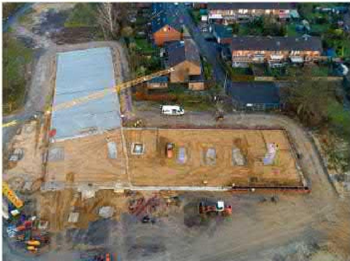
Der Auftakt der Bauphase erfolgte im September 2021. Mit intensiven Aufwendungen begannen im Oktober die Erdarbeiten. Trotz des Umstandes von schlechten Bodenverhältnissen konnten alle Fundamente und Vorarbeiten für die Bodenplatte zum Jahresende fertiggestellt werden.
