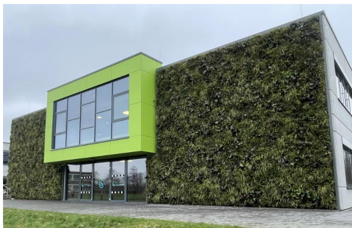
Fassadenbegrünung am Neubau der Gelderner Gesamtschule
