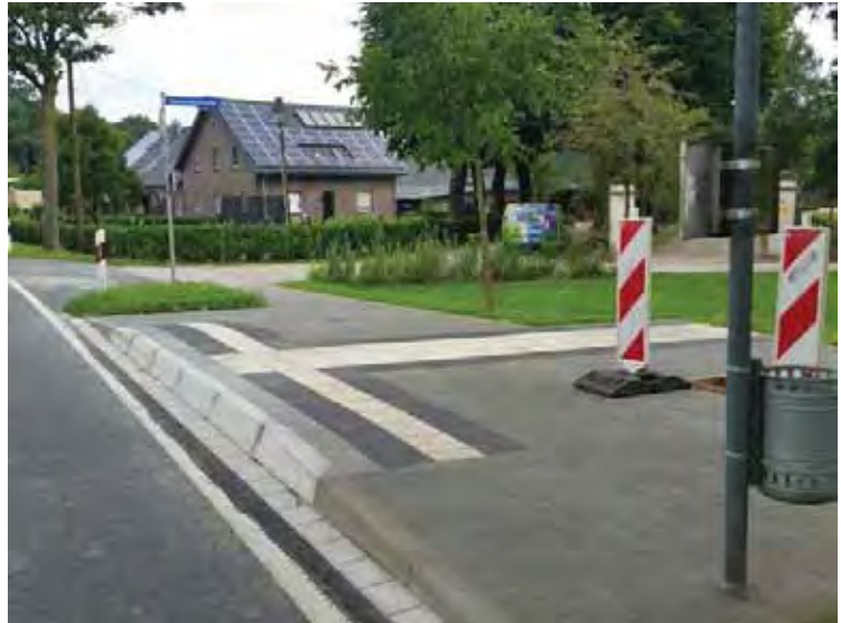
Abb. 5-2: Barrierefreier Haltestellenausbau im Bauprogramm 2016 / 17 (Bild: SDG-V)
