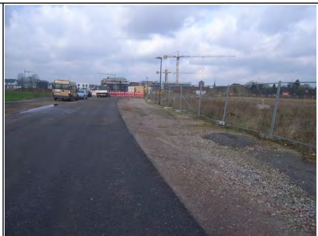
Blick auf die nördlich angrenzenden Baustellen des Berufskollegs (BP Nr. 143).
