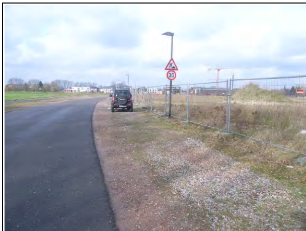
Erschließungsstraße "Am Nierspark".
