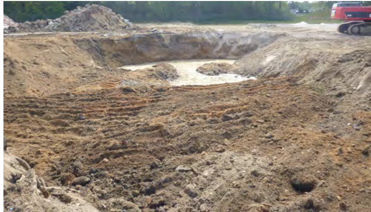
Foto 1: Aushubbereich ehemalige Drehscheibe vor Rückverfüllung
