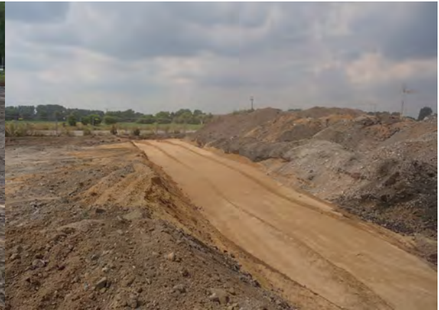
Foto 3: Rückverfüllung Kanal
